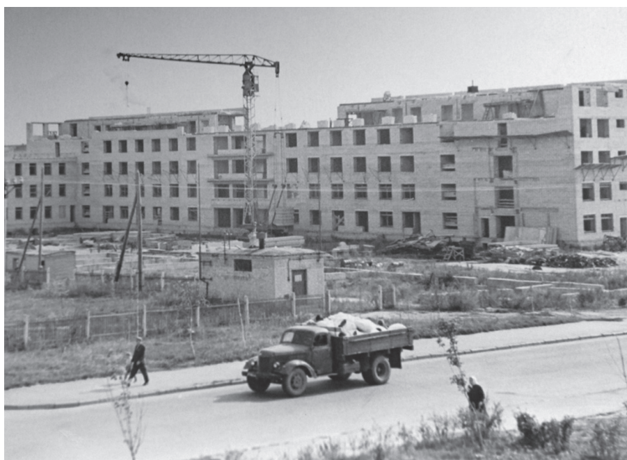
Рис. 4. Строительство нового корпуса стационара. 1966 г.
